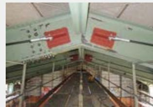
独自製品の耐震CB(ケーブルブレース)等、耐震補強材の開発・供給。
