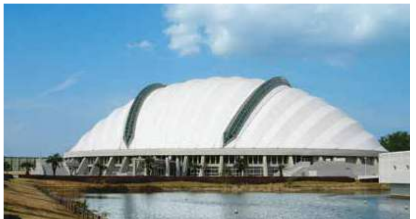
膜押さえケーブル [宮崎県 木の花ドーム]
