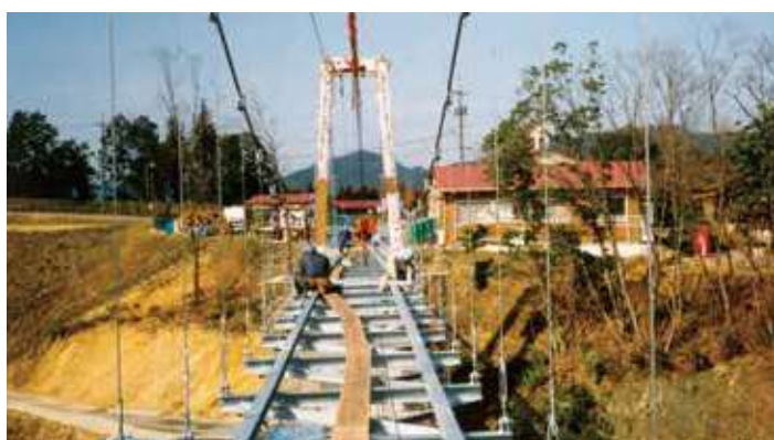
③桁取り付け
