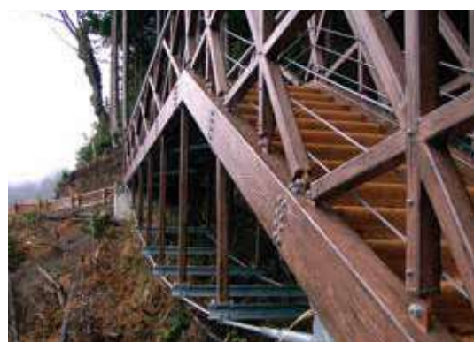
張弦梁式吊橋 [静岡県 本川根人道橋]
