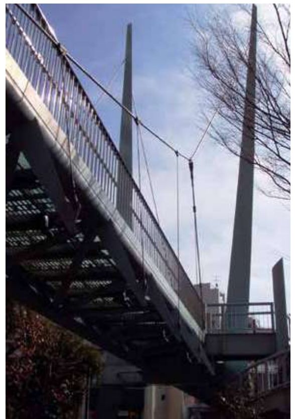
自碇式吊橋(被覆ケーブル) [東京都 代官山人道橋]
