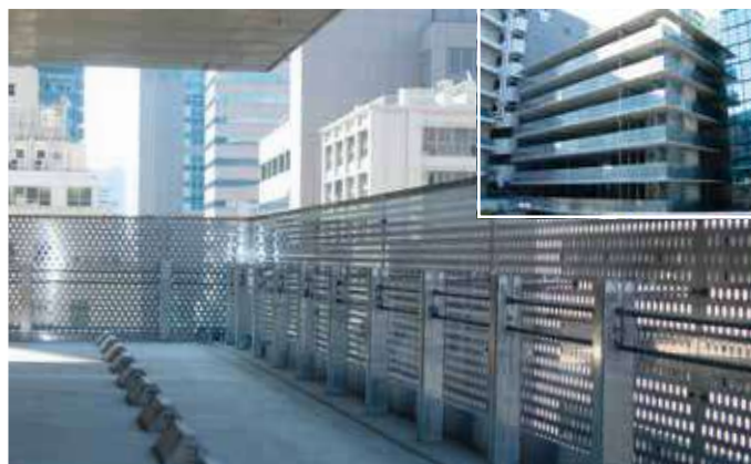
自走式立体駐車場車輛落下防止ケーブル [兵庫県 ストロングビルディング]
