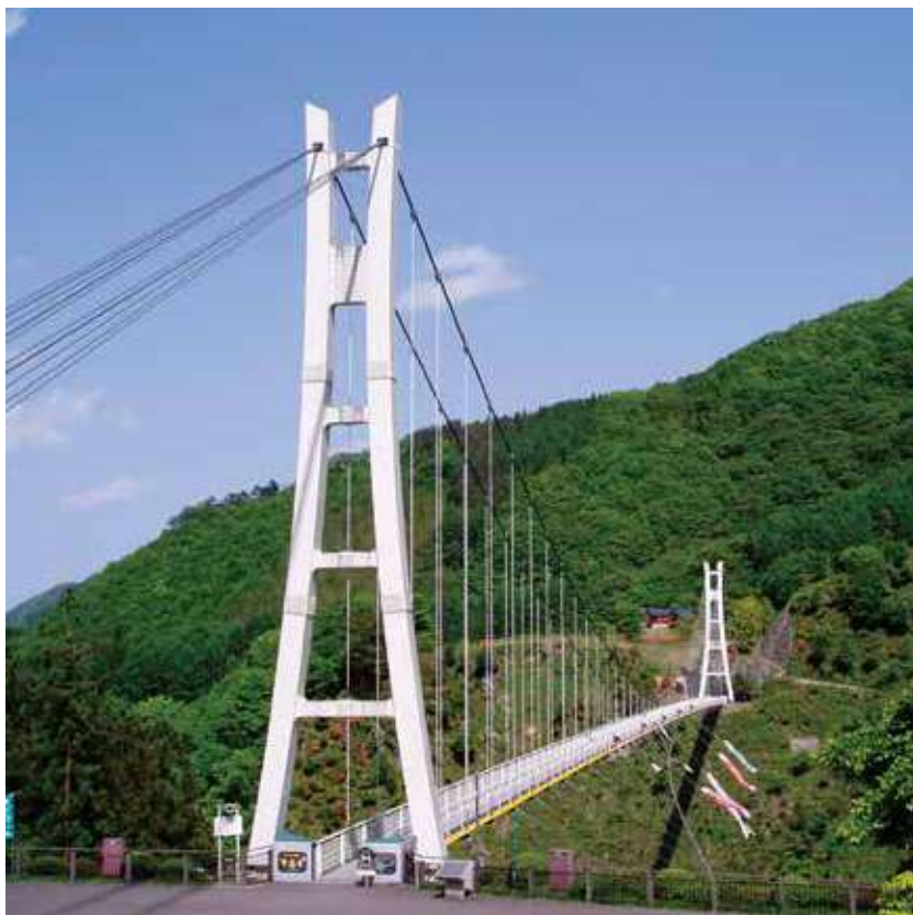
吊橋 [群馬県 上野スカイブリッジ]
