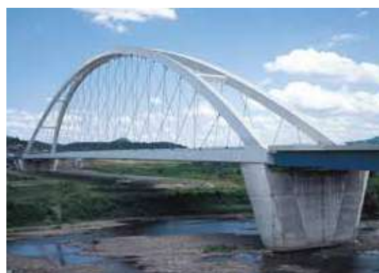
ニールセン橋 [京都府 音無瀬橋]
