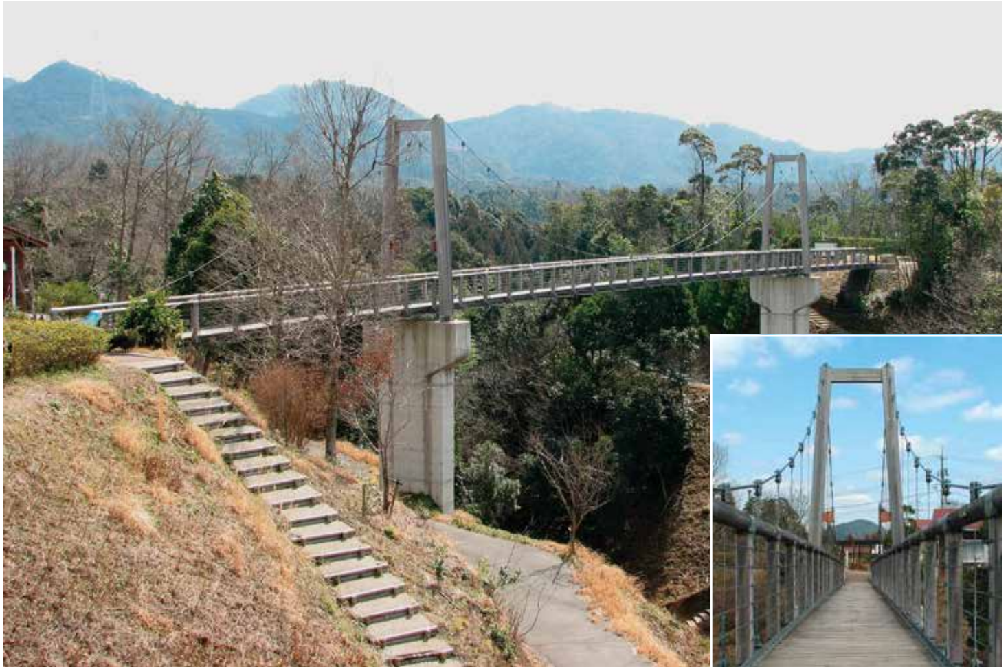
吊橋 [山口県 さえずり橋]
