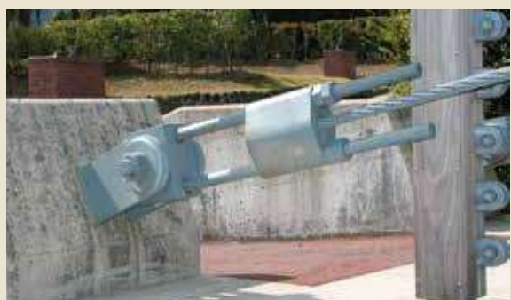
吊橋用調整ソケット（連結ブロック定着）
