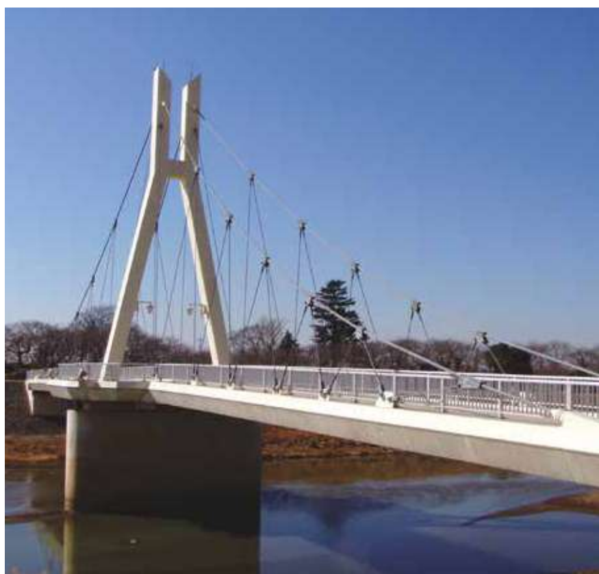
自碇式吊橋 [埼玉県 外野橋]
