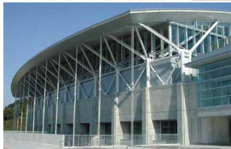
張弦梁ケーブル [静岡県 小笠山総合運動公園 エコパアリーナ]
